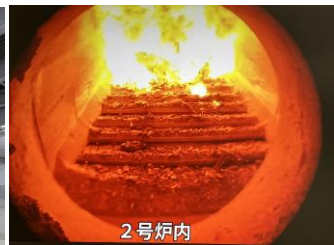
※焼却炉内の様子※
